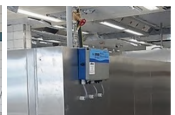
Beispiel: ARCANDIS Peredos 2P-IC / 3P-IC Dosieranlage direkt an der Spülstraße
